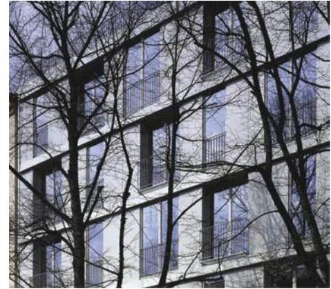
>> Baugruppenprojekte bieten durchdachte Detaillösungen: Die zurückgesetzten Fenster lassen sich um 180 Grad nach innen öffnen und bilden dadurch eine Loggia. (Vgl. Projekt\_02)
